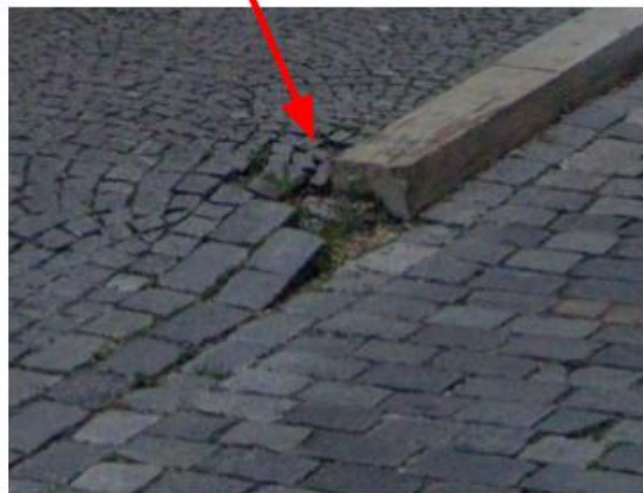
Nahradit kostky žulovými náběhy. 11 x vjezd
